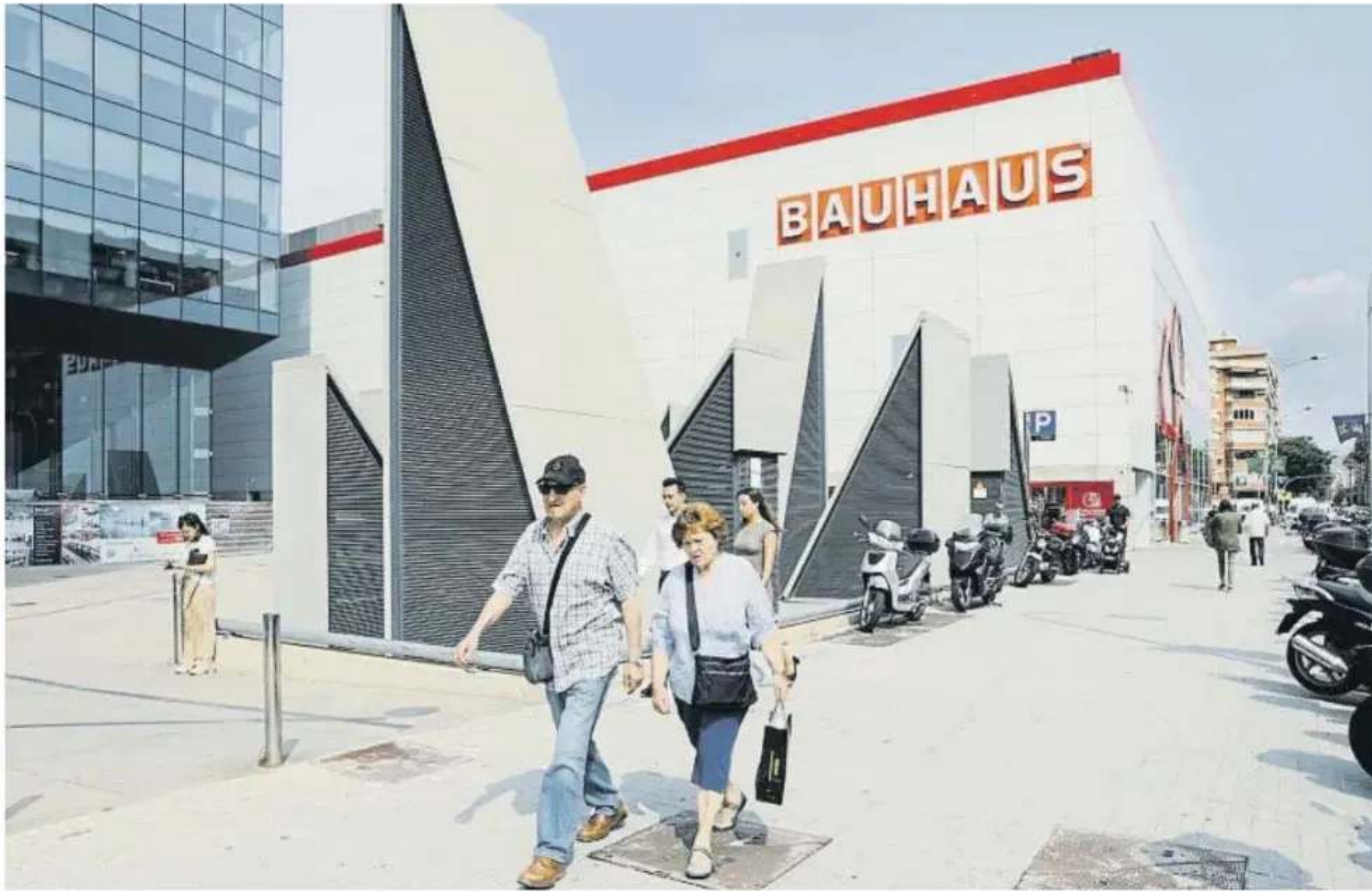
El edificio de la tienda Bauhaus, situada en el paseo de la Zona Franca, y que fue inspeccionado de forma irregular por una subcontrata
